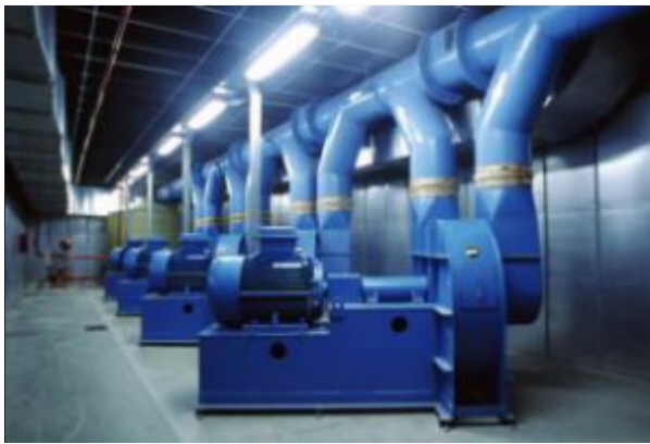
Turbo extracteurs créant l'aspiration
