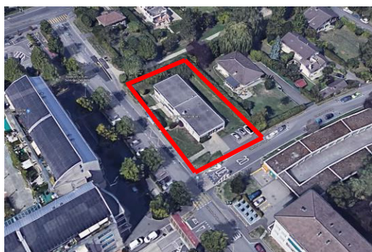
Vue aérienne du bâtiment
