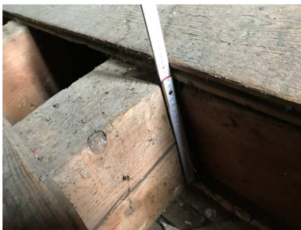
Figure 4 Plancher des combles.
